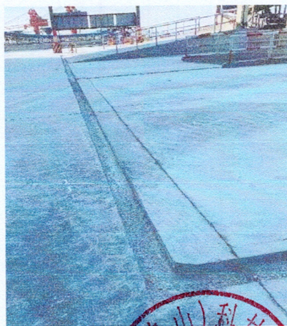
图3 混凝土搅拌机清洗废水处理设施：四周管沟
