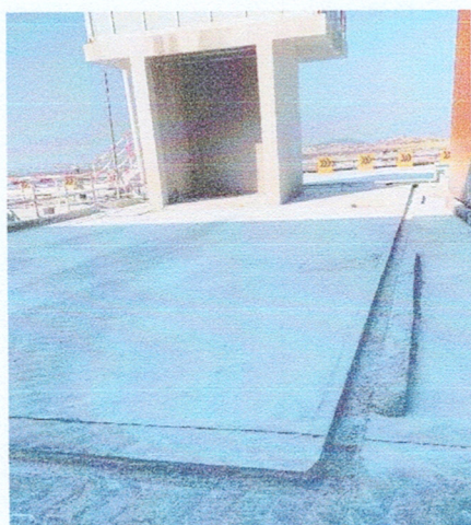
图3 混凝土搅拌机清洗废水处理设施：四周管沟
