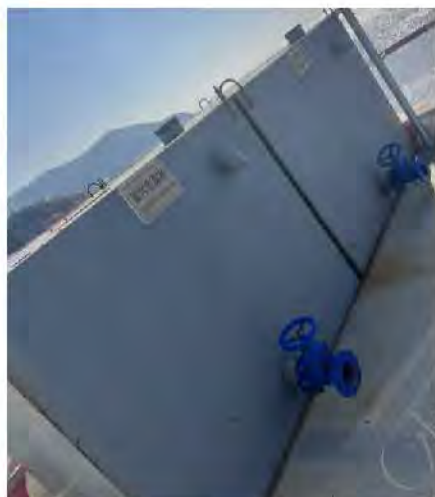
材料码头船舶含油污水、船舶生活污水收集池 出运码头船舶含油污水、船舶生活污水收集池
