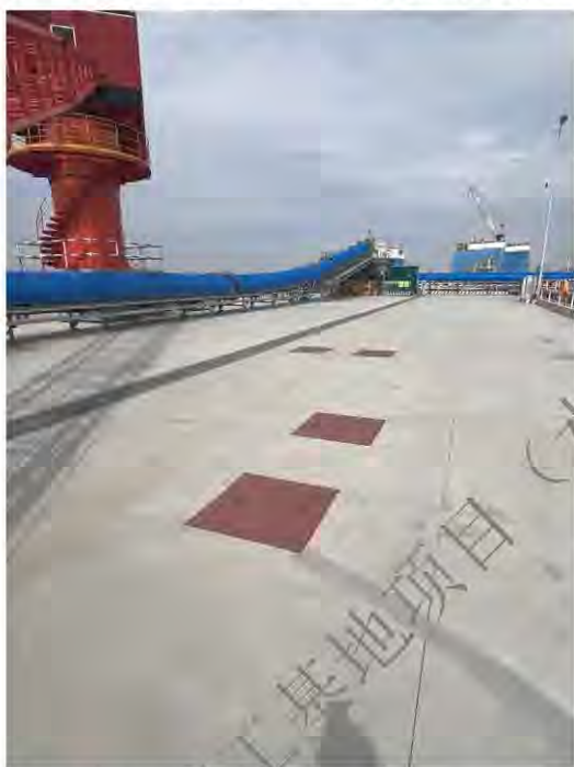
材料码头收集沟及初期雨水收集池
