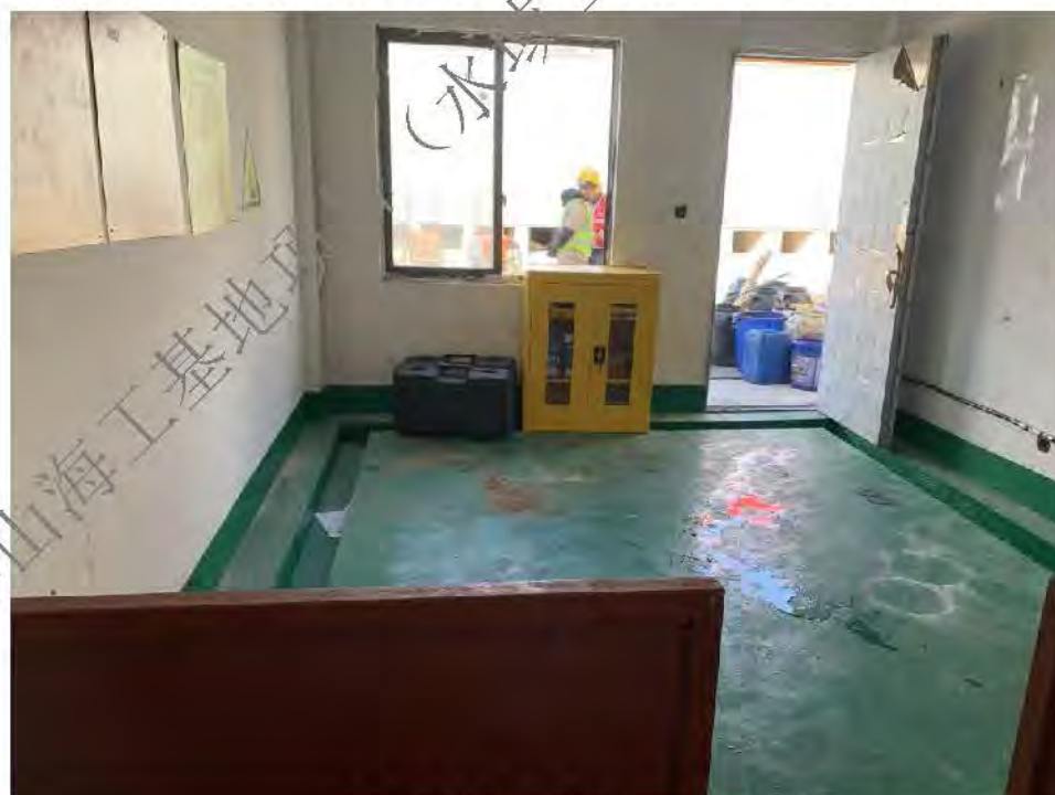
危废暂存间墙上标识、消防设施
