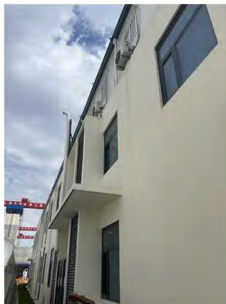
后方陆域食堂油烟屋顶排放
