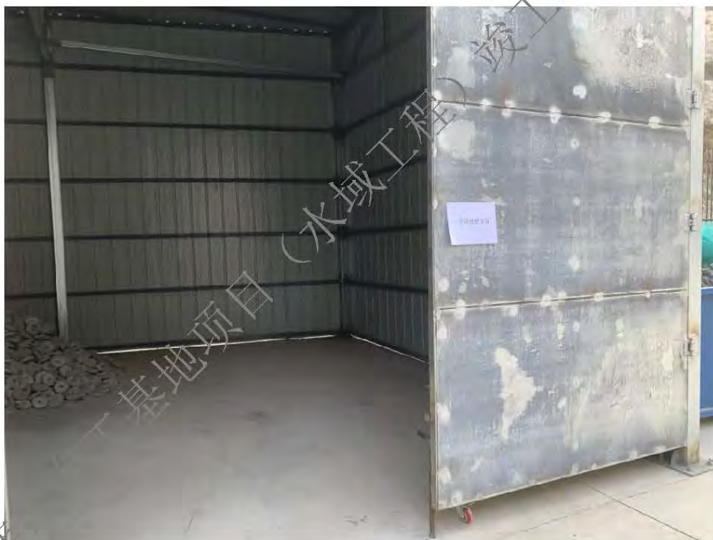
一般固废暂存间
